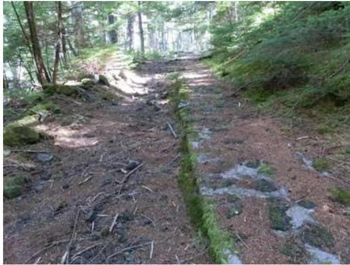
半分の幅だけ石張りのコンクリート舗装がある
